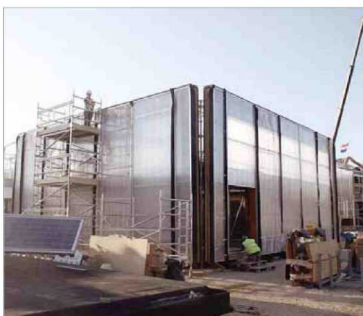
El prototip d'edifici Ressò que es construeix a París ■ UPC
